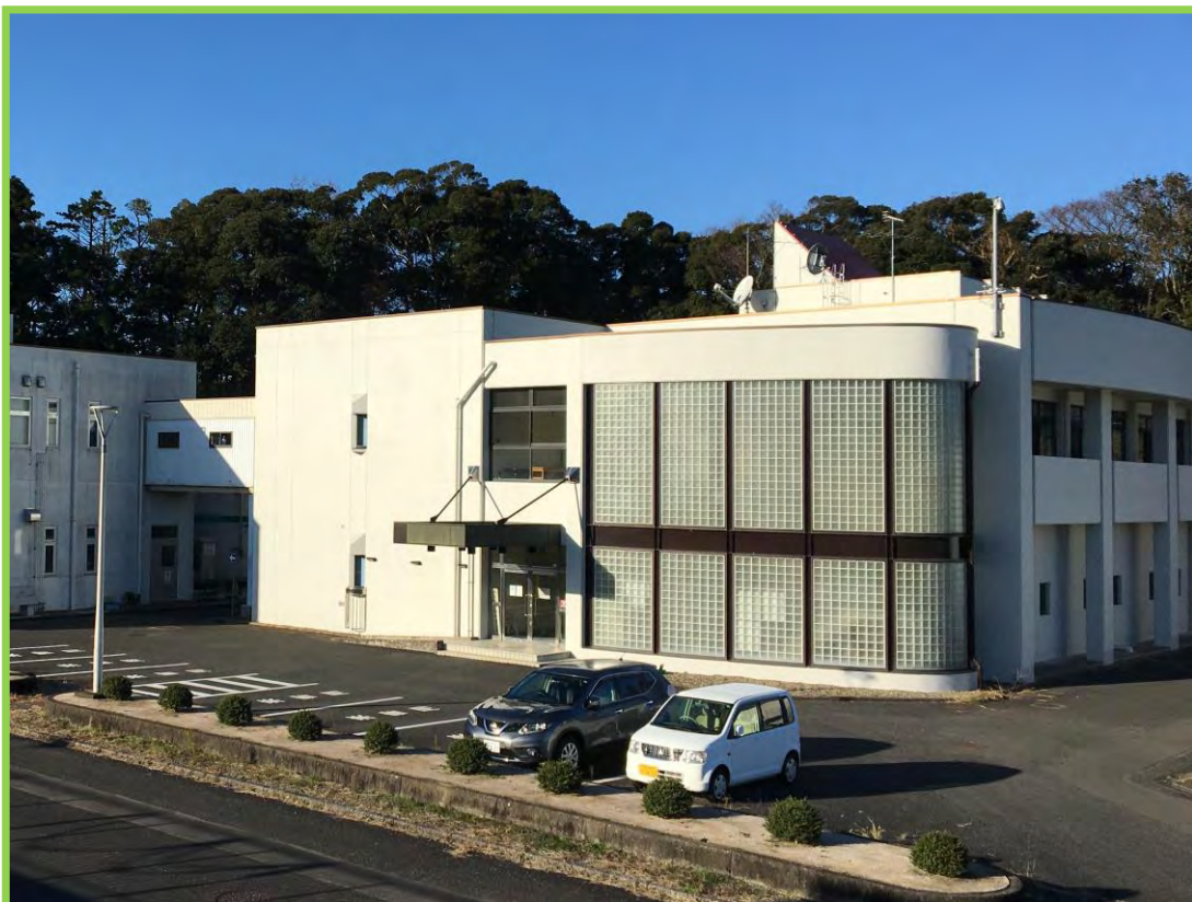
大多喜浄水場 管理本館
