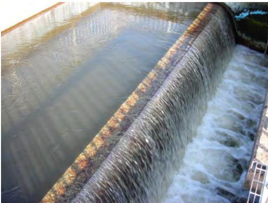
浄水場着水井(原水:浄水場入口)
