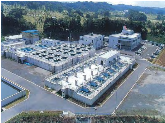
大多喜浄水場
