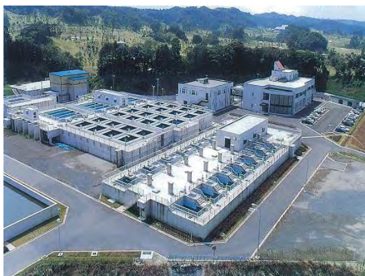
大多喜浄水場
