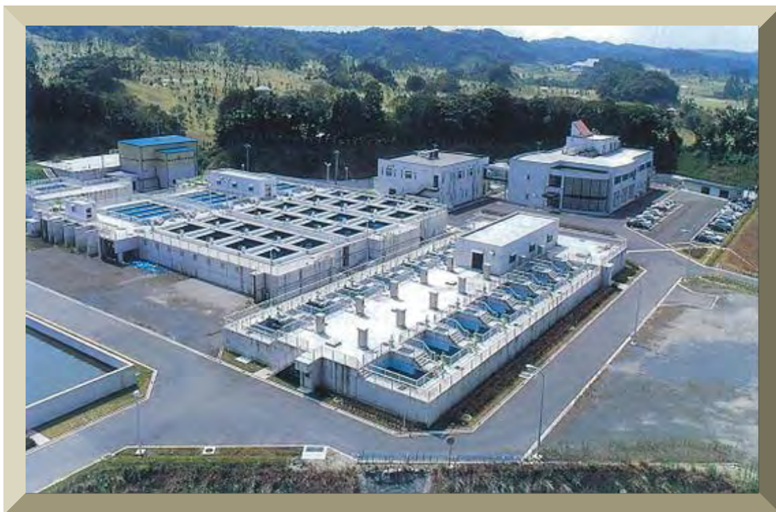
大多喜浄水場
